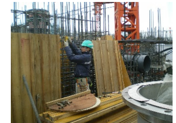
【コンクリートを流し込むための型枠を組み立てる様子】
