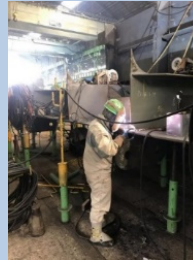
溶接作業の様子
