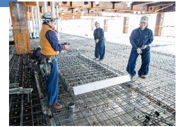
【鋼製型枠を鉄筋上に取付ている作業風景（左が外国人材）】
